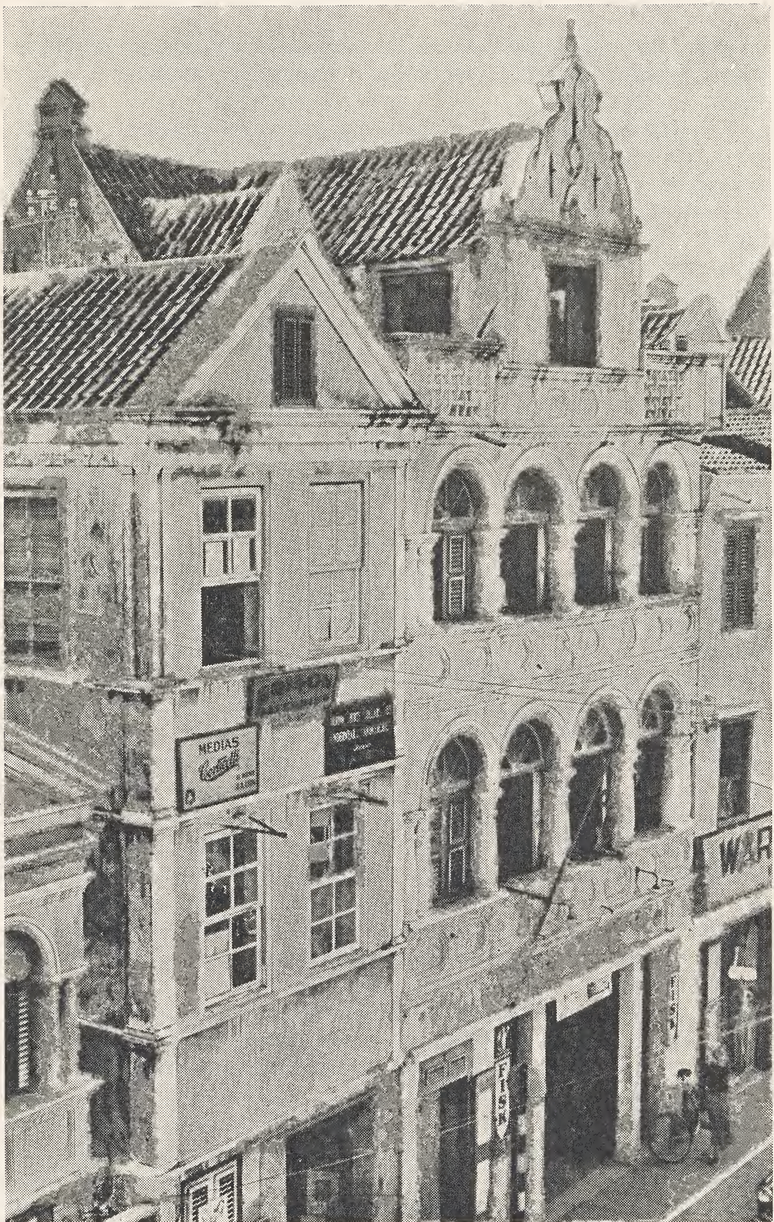
Oude Curaçaose bouwstijl van herenhuizen annex winkelpanden. FOTO: FISCHER. 22
